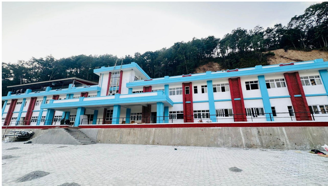
निर्माणाधीन प्राथमिक नगर अस्पताल र १३ नं. वडाको स्वास्थ्य चौकी भवन
