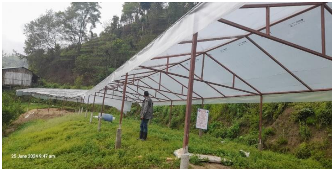
मेलम्ची नगरपालिकाको सहयोगमा तयार गरिएको फलामको फ्रेम सहितको प्लाष्टिक टनेल
